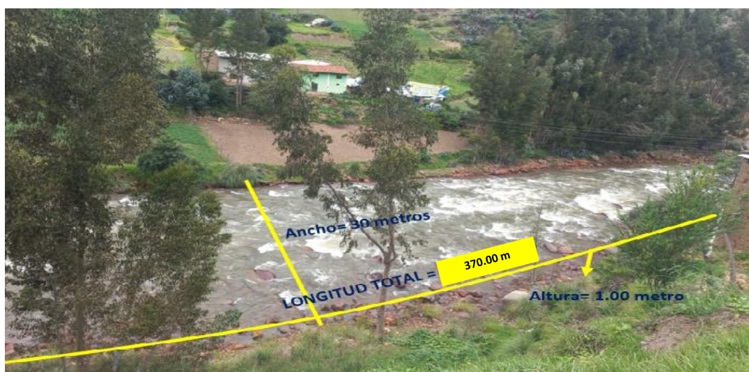
VISTA N° 2: TRAMO GENERAL DEL MARGEN DEL RIO SANTA - ACO CON PUNTO INICIAL E= 227035; N= 8932556.00 Y PUNTO FINAL E= 226948.00; N= 8932908.00, DONDE SE REALIZARA LA DESCOLMATACION DE CAUCE Y CONFORMACION DE BORDO EN EL MARGEN DERECHO
