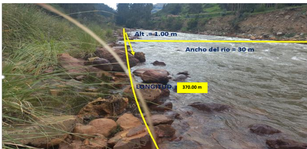
VISTA N° 2: TRAMO GENERAL DEL MARGEN DEL RIO SANTA - ACO CON PUNTO INICIAL E= 227035; N= 8932556.00 Y PUNTO FINAL E= 226948.00; N= 8932908.00, DONDE SE REALIZARA LA DESCOLMATACION DE CAUCE Y CONFORMACION DE BORDO EN EL MARGEN DERECHO
